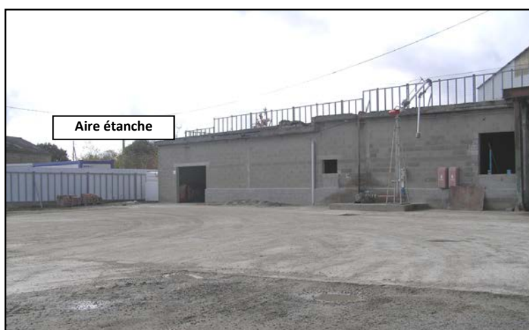
Les citernes de carburant sont placées à l'intérieur de la partie maçonnée.
